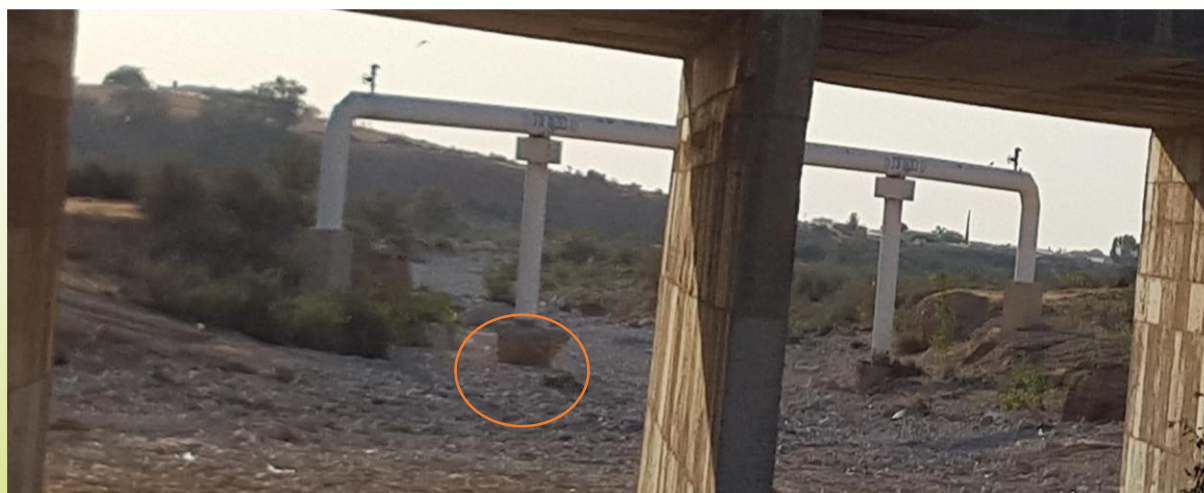
תמונה 26 - חשיפת ניצבי גשר צינורות של חברת "מקורות" באפיק נחל רביבים
