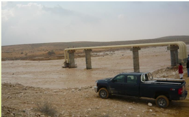
גשר צינורות של "מקורות" היה מתוכנן מעל כל האפיק. עקב התחתרות של הגדה, הניצב השמאלי של הגשר נמצא עכשיו במרכז הזרימה.
