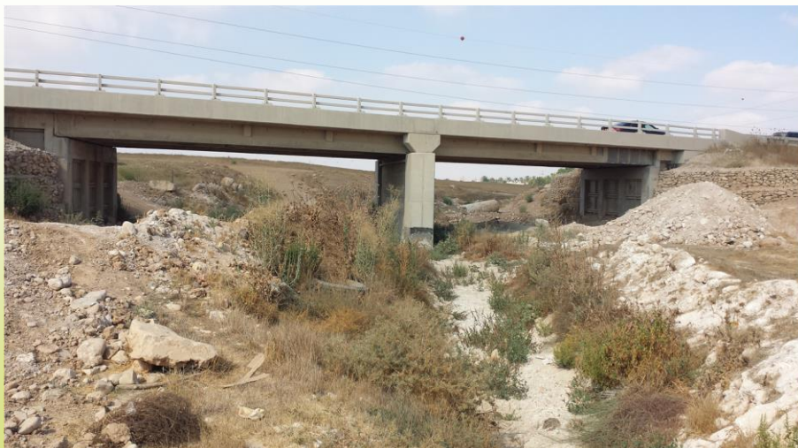
תמונה 17 – ניצבי גשר כביש 31 בתוך ערוץ נחל חברון
